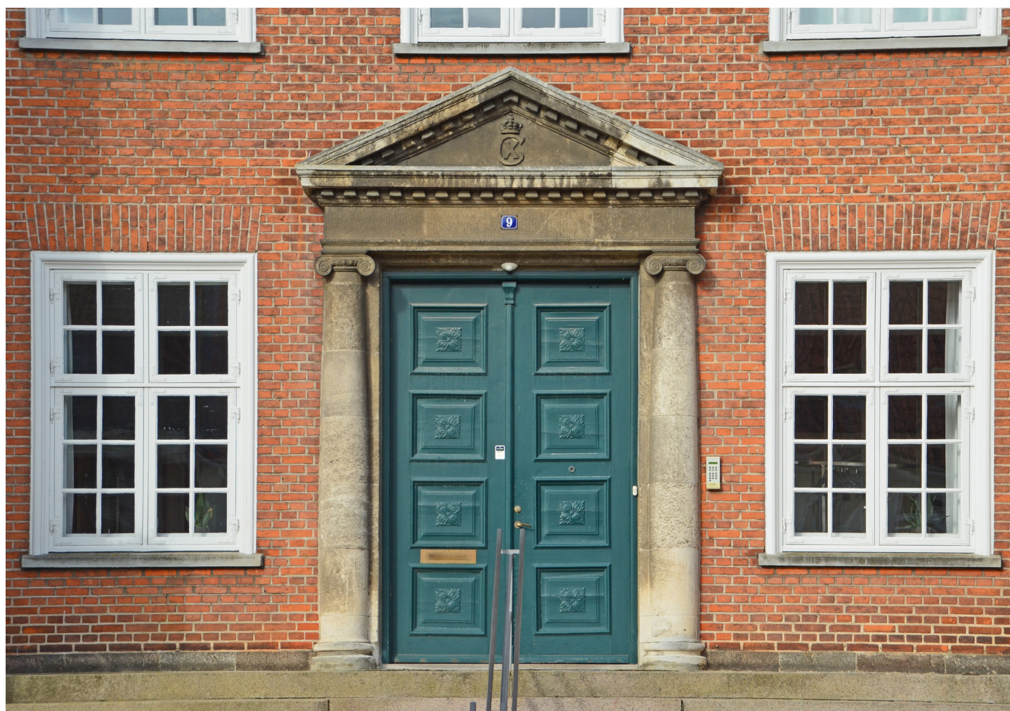
Hovedindgangen indrammet af joniske søjler og trekantfronton.
