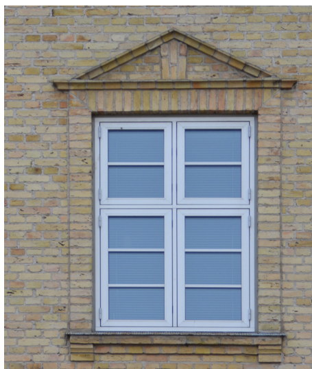
Vinduesindfatning med fronton og slutsten.
