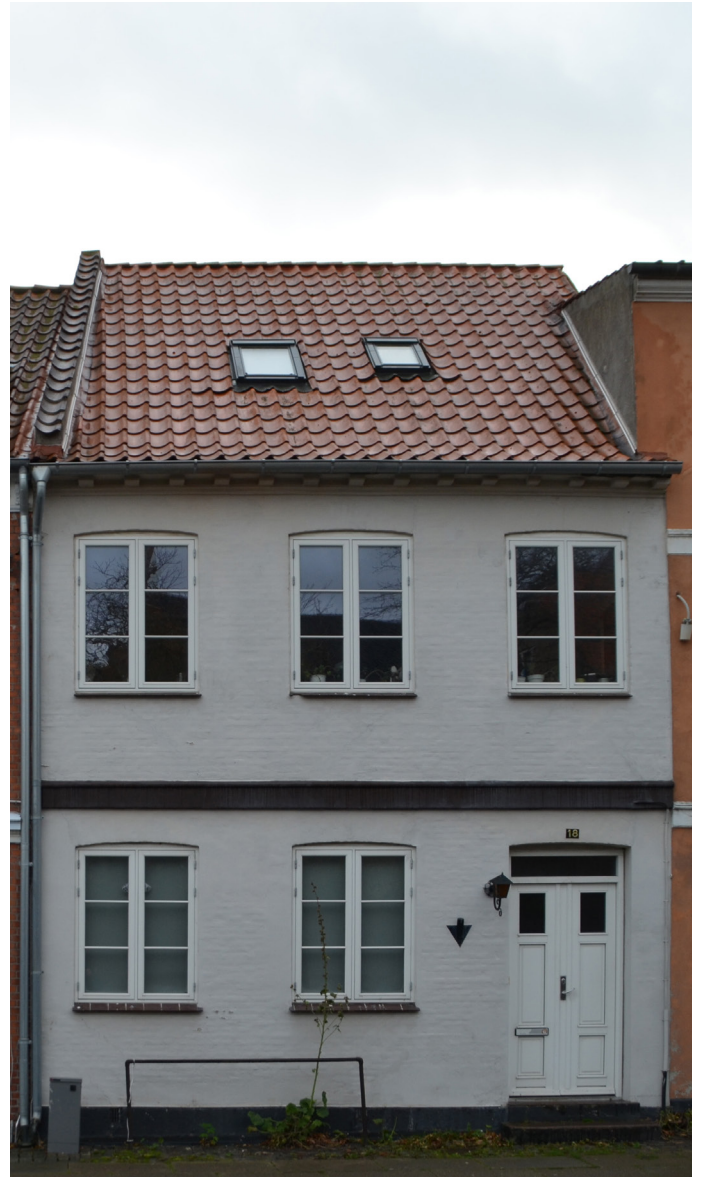
Skippergade 18 med en typisk senklassicistisk facade fra 1855 bestående af malet grundmur delt af en kordongesims og med fladbuestik over muråbninger.
