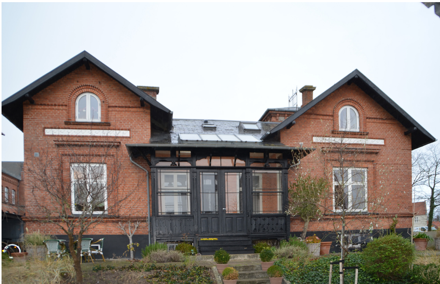
Havesiden af Kongens Bastionsvej 3 opført omkring 1890.
