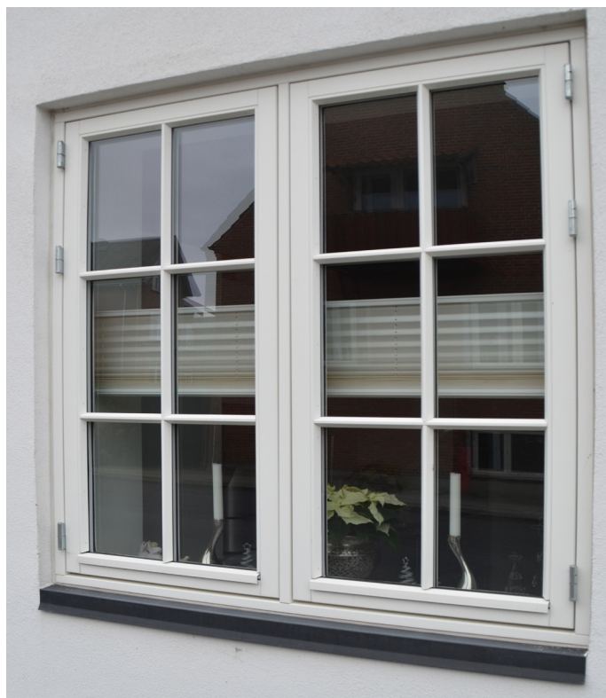
Nyt vindue med to hele termoruder hver visuelt opdelt i 6 små ruder ved hjælp af indbyggede afstandsprofiler dækket af pålmede sprosselister.
