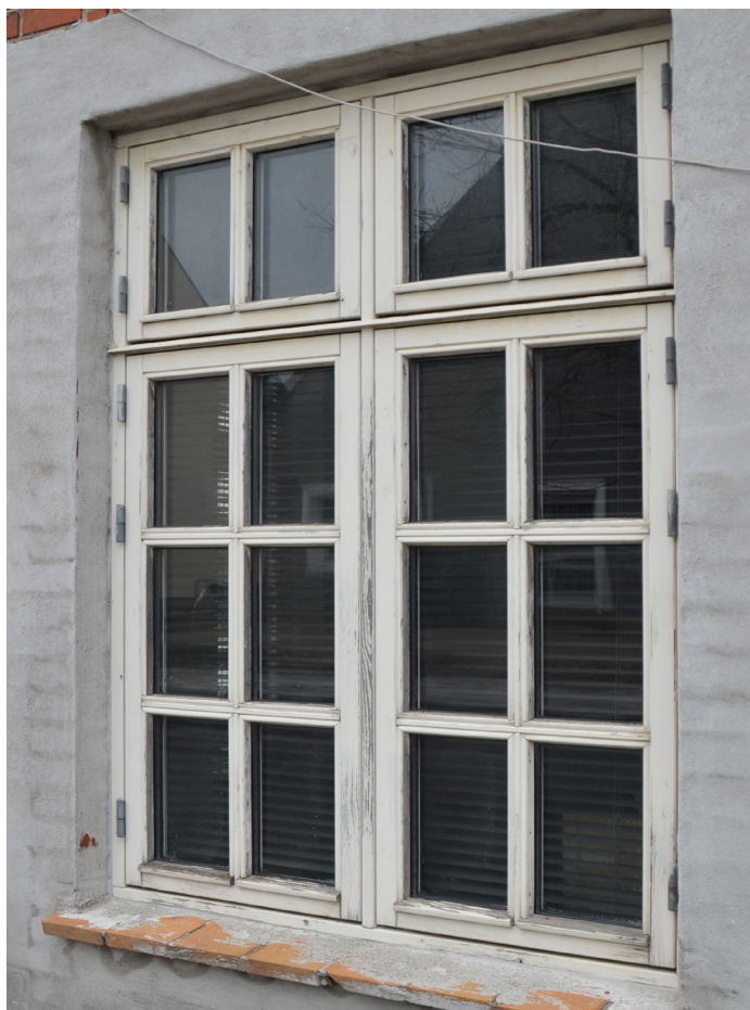
Nyere småsprosset vindue med 16 små termoruder isat med glaslister.
