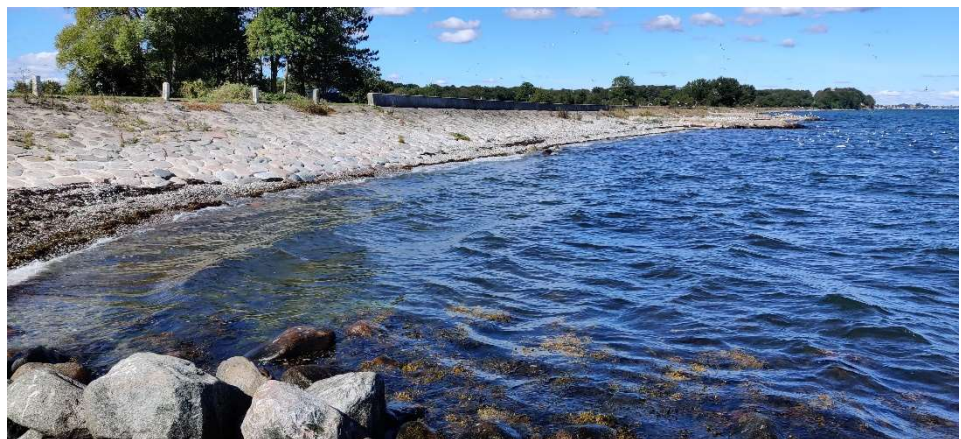
Figur 4.65: Foto af stenglacis og betonmur.
