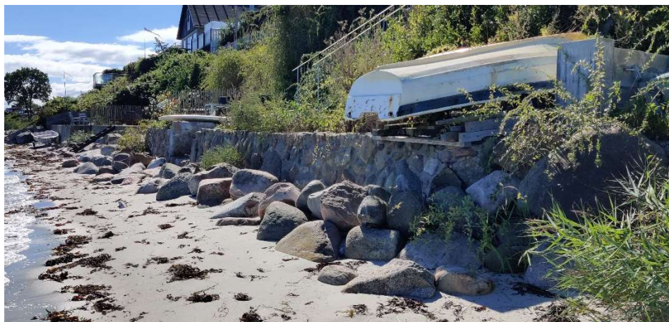
Figur 4.59: Foto af forskellige former for erosionsbeskyttelse.
