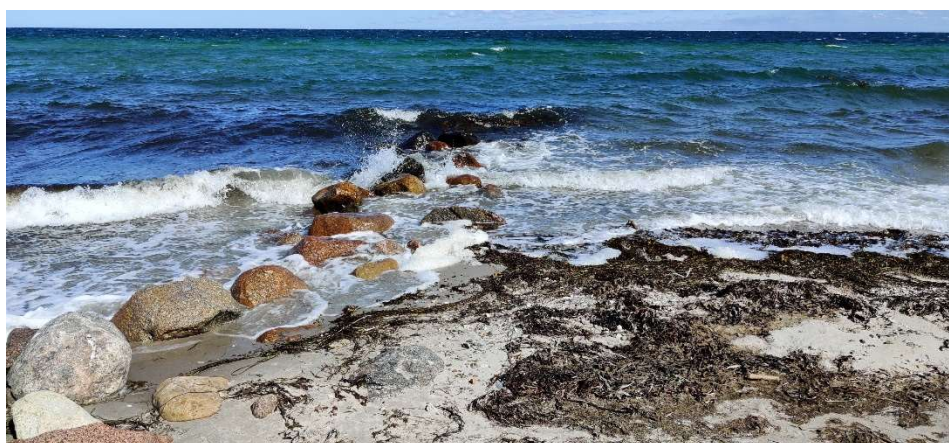
Figur 4.52: Foto af høfde, der er faldet sammen.
