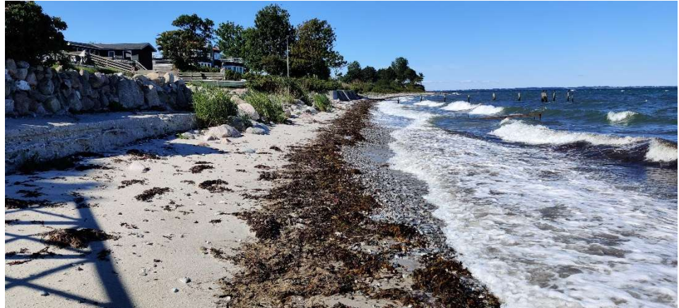
Figur 4.43: Skråningsbeskyttelse foran bebyggelse.
