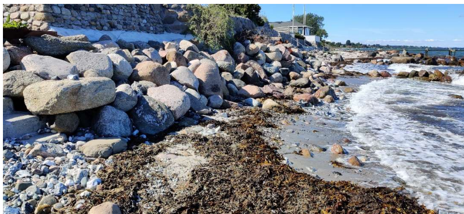
Figur 4.46: Foto af skråningsbeskyttelse på strækningen mellem St. 1090-1112. Stranden er her smal. Dette kan både skyldes, at beskyttelsen er bygget ud på stranden, og en øget erosion af stranden forårsaget af skråningsbeskyttelsen.
