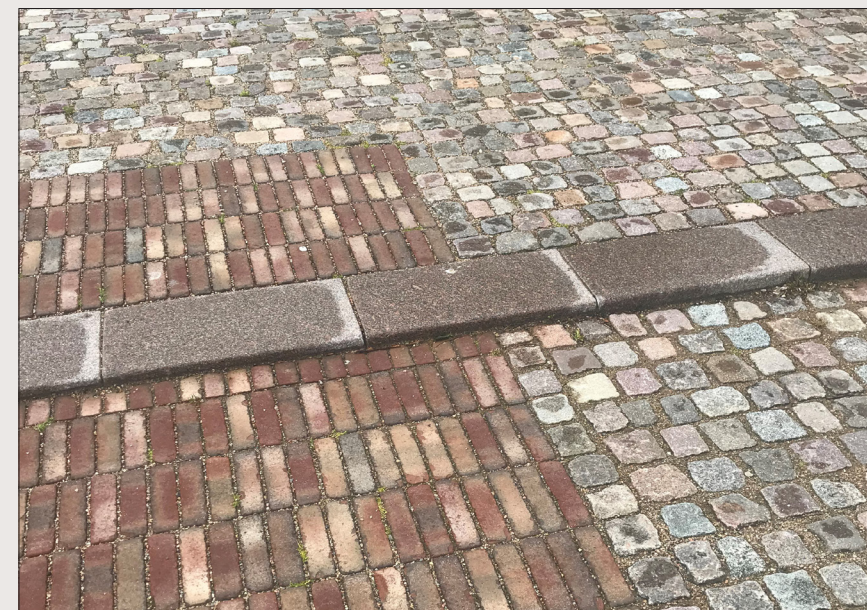
Blanding af nye sten og genbrugte sten i Grenå De genbrugte chaussésten er blandet med nye formater og tegl
