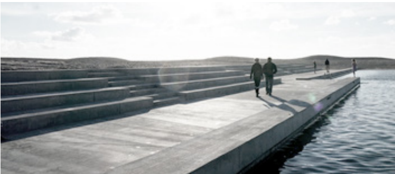
betontrappe langs kajkant skaber adgang til vandet
