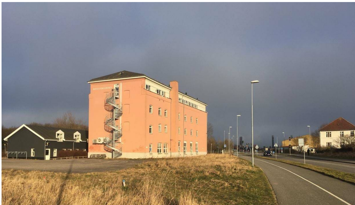
Foto af de eksisterende bygninger på Bryggerivej. Pakhusbygningen er registreret som bevaringsværdig, men tillades nedrevet med vedtagelse af lokalplan 330.
