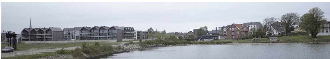
Figur 12: Fra vandet kan en ny bebyggelse næsten ikke ses idet Nyborg Destilleri ligger foran bebyggelsen set fra vandet. Billedet er taget ca. 250 m fra kysten.
