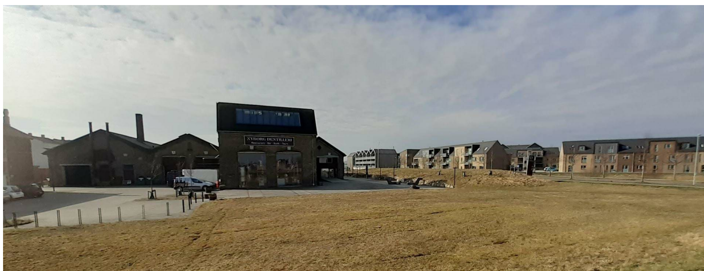
Figur 5: Syd for lokalplanområdet ligger Nyborg Destilleri.
