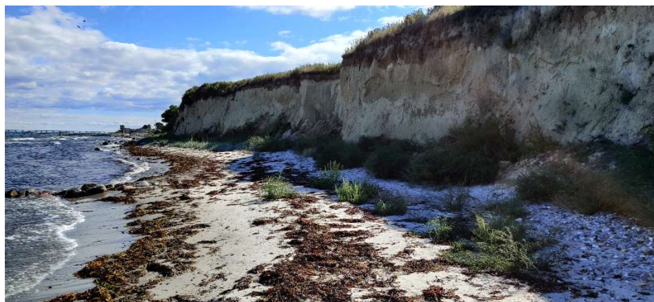
Figur 4.37: Ubeskyttet skrænt mellem St. 985-995. Høfden, der ses på billedet, ligger i slutningen af den ubeskyttede strækning, og er den eneste høfde på strækningen.
