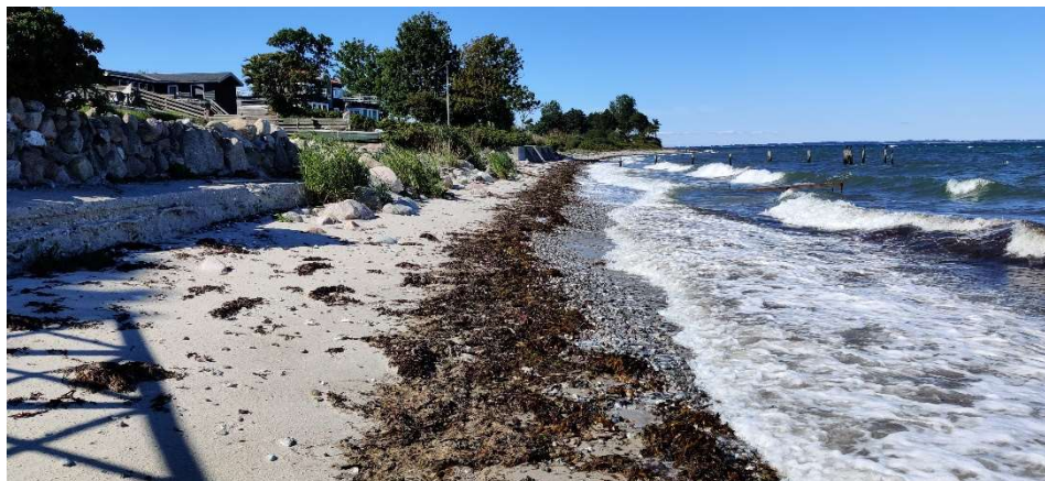
Figur 4.43: Skråningsbeskyttelse foran bebyggelse.
