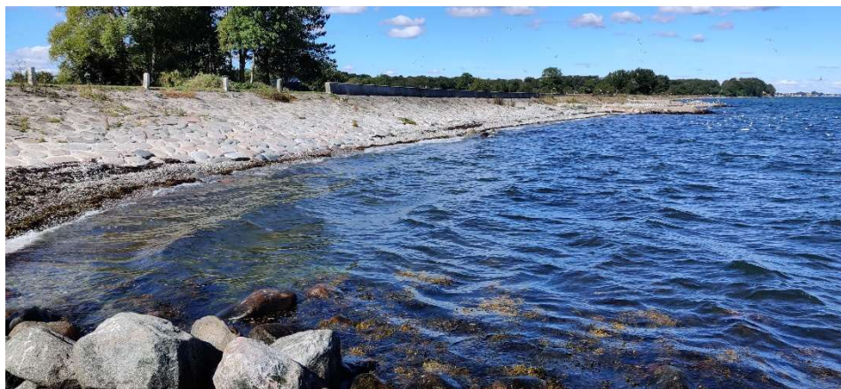
Figur 4.65: Foto af stenglacis og betonmur.
