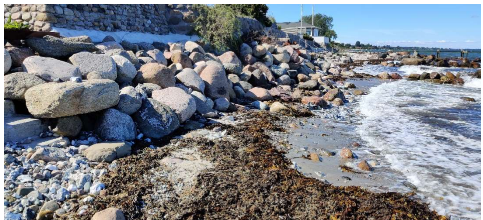
Figur 4.46: Foto af skråningsbeskyttelse på strækningen mellem St. 1090-1112. Stranden er her smal. Dette kan både skyldes, at beskyttelsen er bygget ud på stranden, og en øget erosion af stranden forårsaget af skråningsbeskyttelsen.
