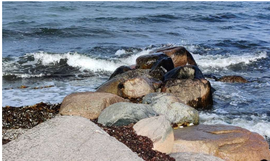
Figur 4.23: Foto af stabil opbygget høfde.
