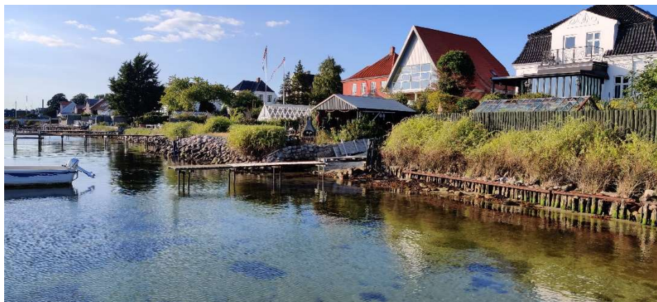
Figur 4.15: Foto af erosionsbeskyttelse foran haver langs Kystvej. Palisadevæggen er i dårlig stand
