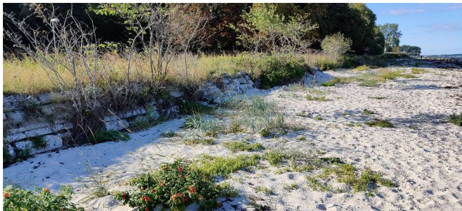
Figur 4.25: Foto af skråningsbeskyttelse.
