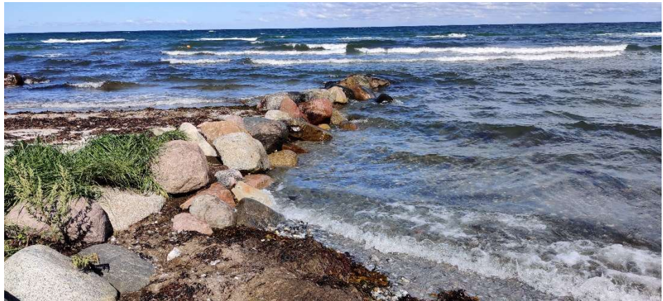
Figur 3.4: Foto af en hofde opbygget af sten med luvsideaflejring (til venstre) og læsideerosion (til højre). Fotoet er taget under kystinspektionen d. 1/9-2020.
